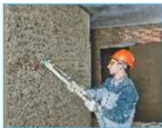
Рис. 5.16. Технология лепки из глины (а); нанесение штукатурки (б)
